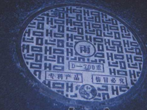
本公司专利检查井盖埋妥在车公庄道路 承载能力达480KN以上
