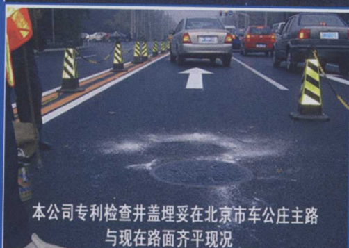
本公司专利检查井盖埋妥在车公庄道路 承载能力达480KN以上
