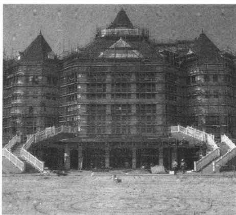
图 1-5 迂回曲折的建筑物外形
