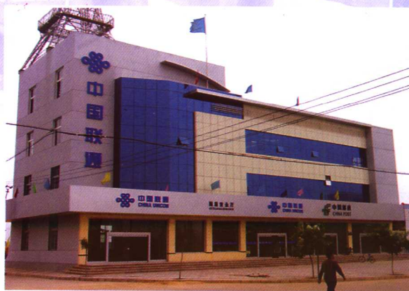
固原分公司办公楼
