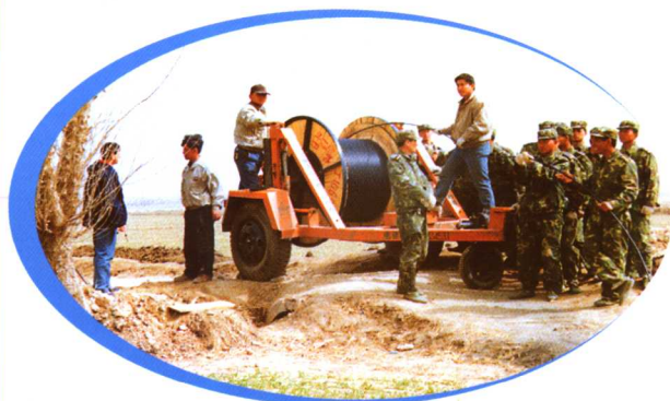
光缆干线施工现场
