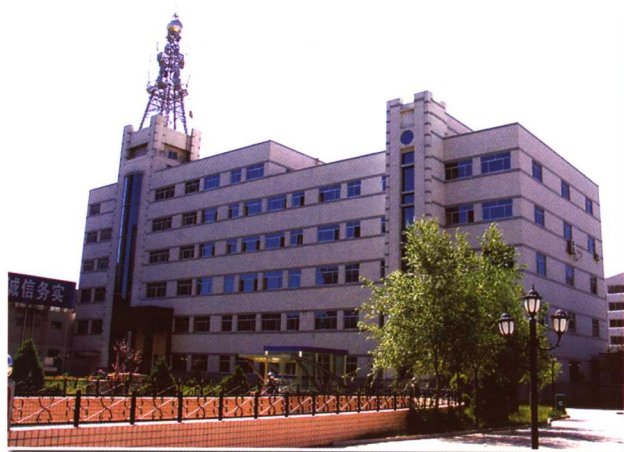
宁夏分公司机房大楼
