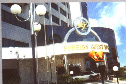
公司负责自治区重点工程之一——南宁造纸厂二栋外宾楼（三星级）装修整体设计与施工
