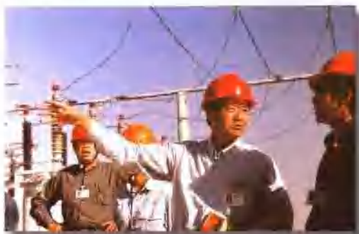
局长袁宁谦(中)在变电站检查指导工作
