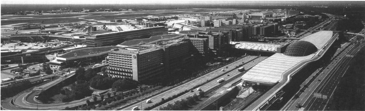
图3 法兰克福机场的空铁（Airrail）车站
