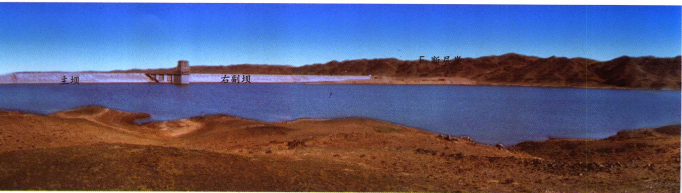
▲某水利枢纽大坝与 F 1 影像
