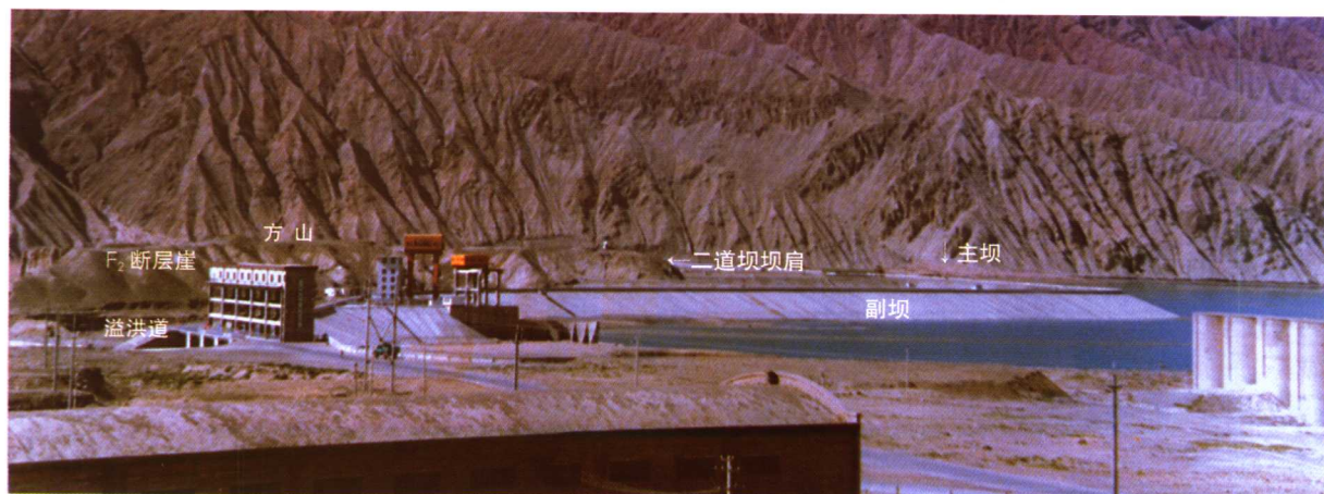
▲克孜尔水库副坝全景
