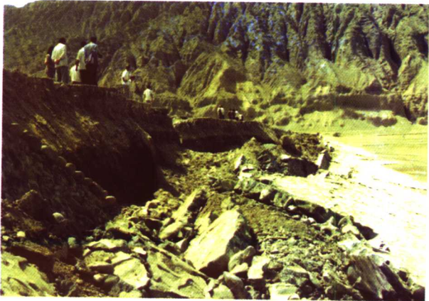
▲乌恰 1965 年 7.1 级地震，喀什一级电站 大坝坝前滑塌(施体强摄)
