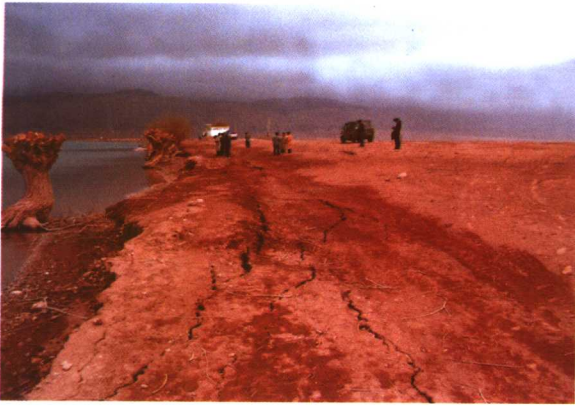
▲1996.3.19 阿图什 6.9 级地震 西克尔水库坝前坡影像
