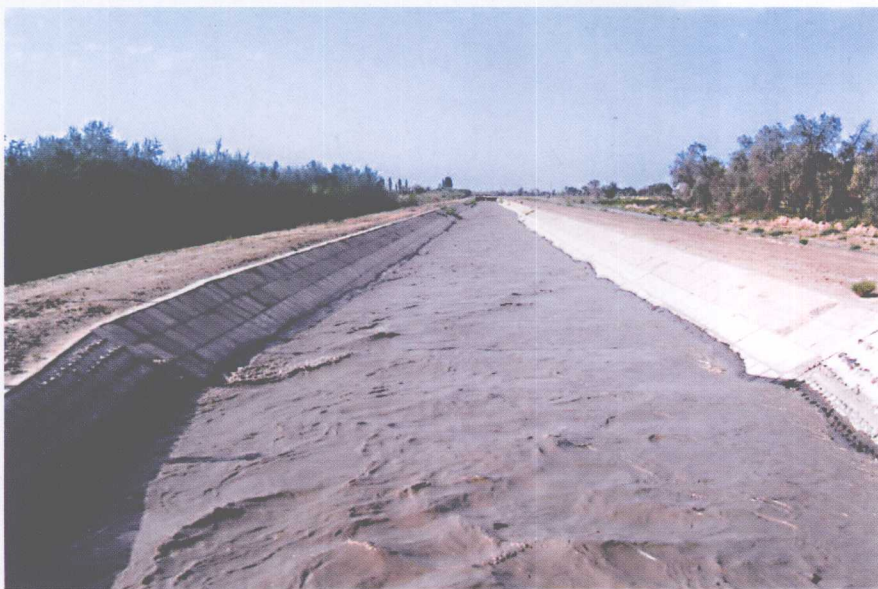
⑥ 现代水工建设——渠系防渗 (干渠西岸大渠防渗) (133 团农场, 2006. 7)
