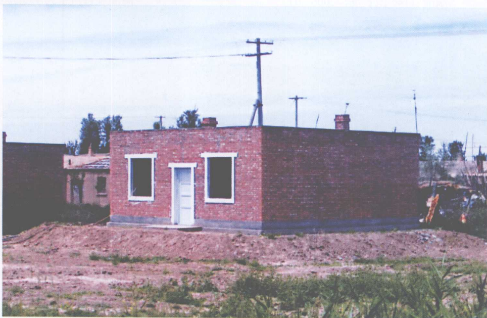
14 盐渍化地区的建设——垫高地基的农工住房 (石河子大学实验农场, 2006. 8)
