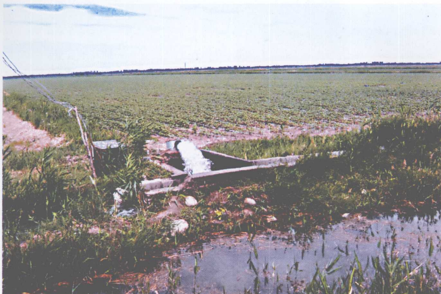
⑤ 现代水工建设——机井灌排 (石河子大学实验农场, 2006. 8)
