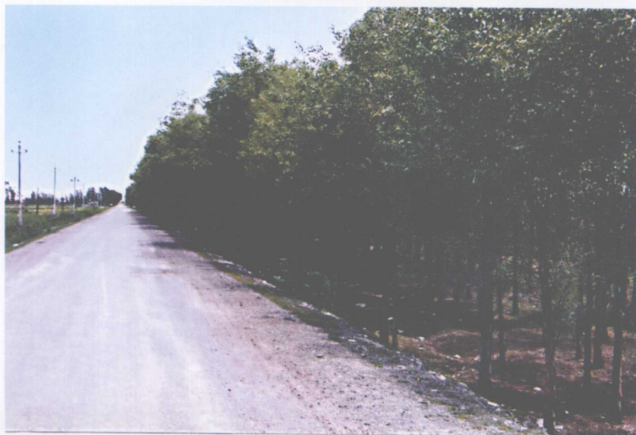
15 盐渍化地区的建设——垫高路面的沥青路 (石河子大学实验农场, 2006. 8)
