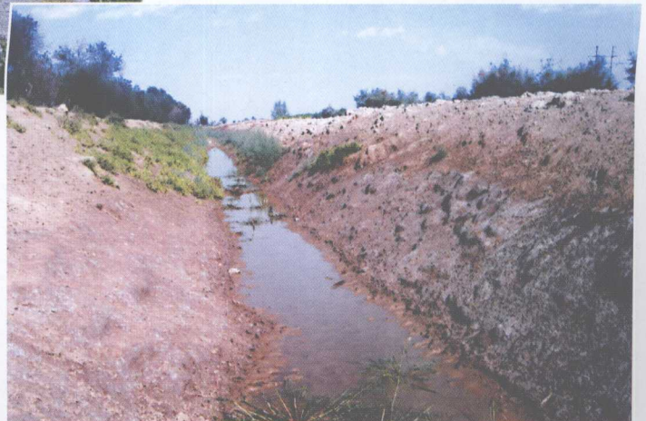
④ 现代水工建设——机挖排渠 (斗排) (133团农场, 2006. 7)
