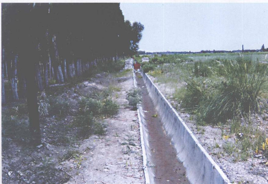
⑦ 现代水工建设——渠系防渗 (斗渠防渗) (石河子大学实验农场, 2006. 6)
