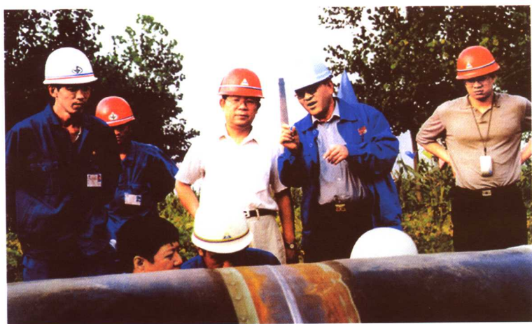
中国石油天然气集团公司党组书记、总经理陈耕（中）在“西气东输”工程一线检查工作。
