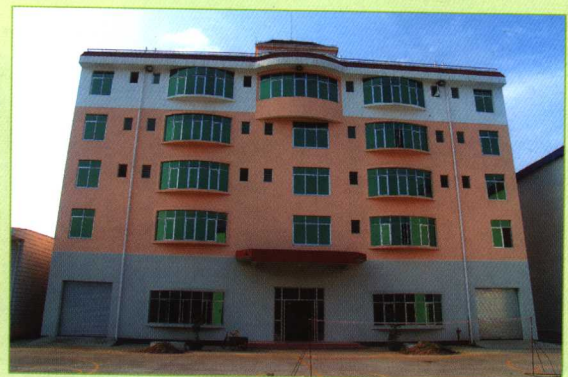
公司质检大楼
