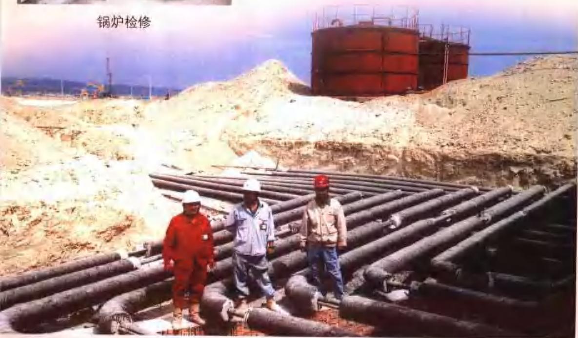
安装重油管线项目建设
