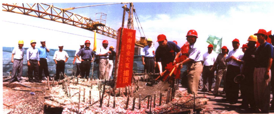
1999年，与河南省重点工程、河南发展文化产业标志性工程——河南报业大厦的建设者一起，为大厦揭顶添上最后一斗混凝土
