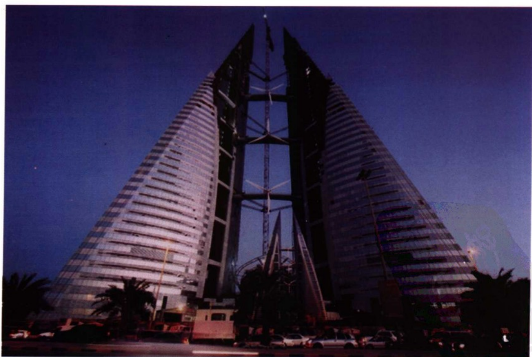
将于2007年底竣工的高240米的巴林世贸中心，它将利用安装在双子塔之间的三座巨大风力涡轮机来为世贸中心提供用电
