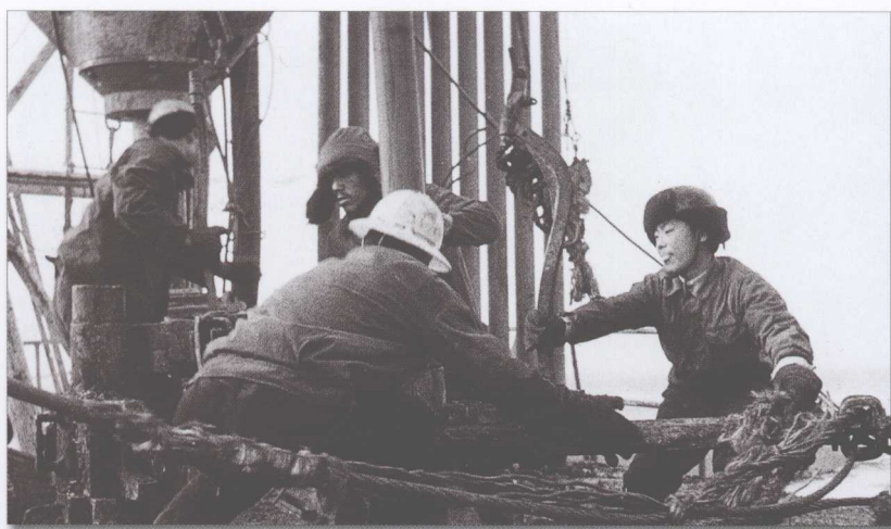
会战时期,由会战工委工作部、钻井工程处组织的钻井升旗劳动竞赛如火如荼,有力地促进了会战目标的实现。图为钻井职工争分夺秒起下钻。
