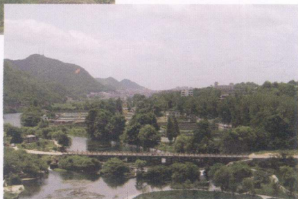
贵州省水产研究所花溪示范基地
