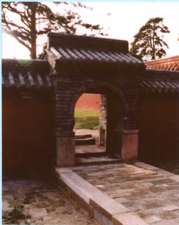
沈阳昭陵“御厠”墙门 (东→西摄)
