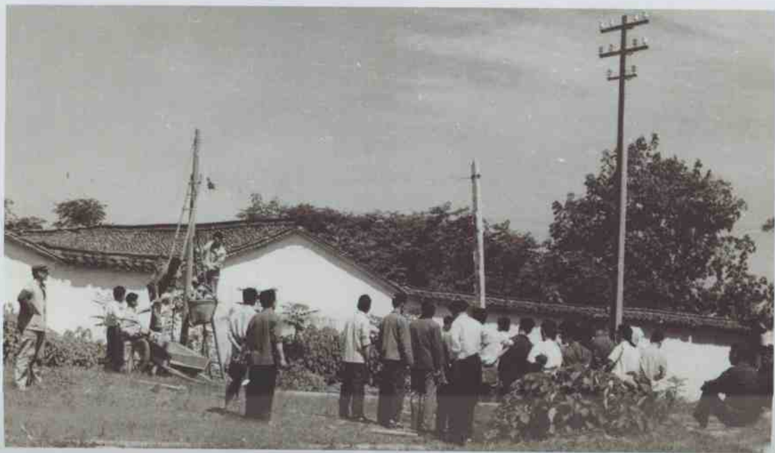
▲ 工程技术人员对广播专用水泥杆进行抗拉强度测试
