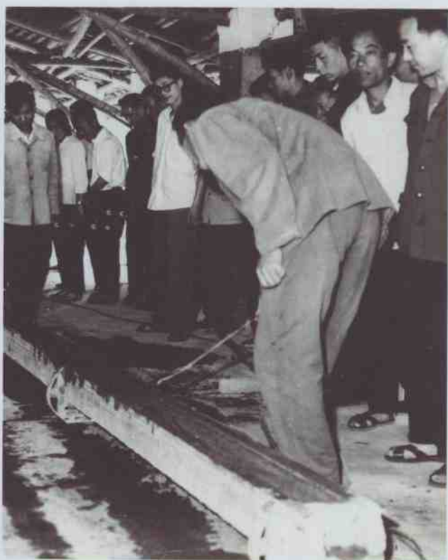
▲ 1963年7月，余杭县广播管理站自力更生生产广播专用水泥杆
