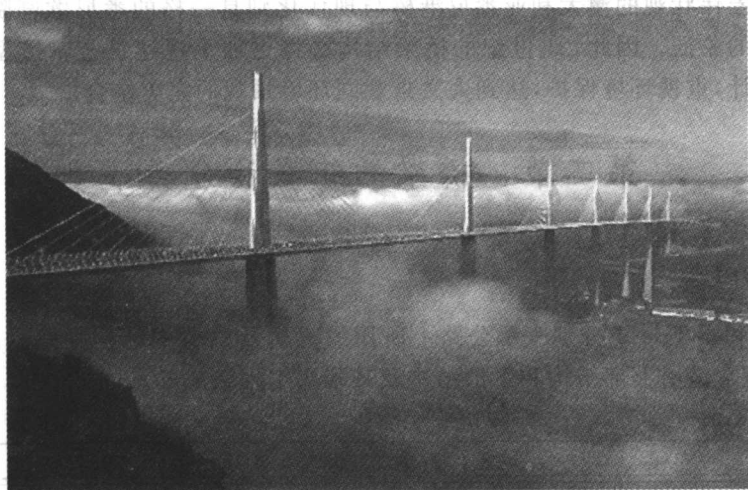
图 1-1-9 法国米约大桥
