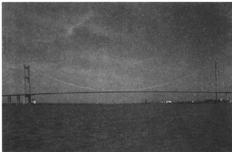
图 1-1-6 润扬长江大桥
