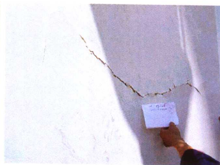
彩图 15 4 号风机叶片裂纹
