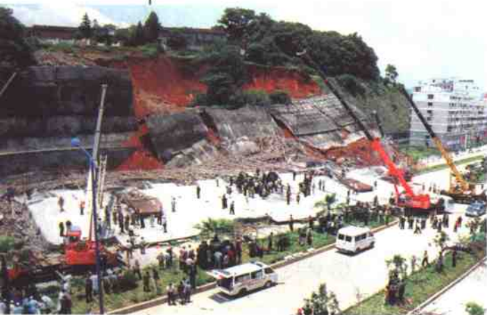
坍塌事故现场
