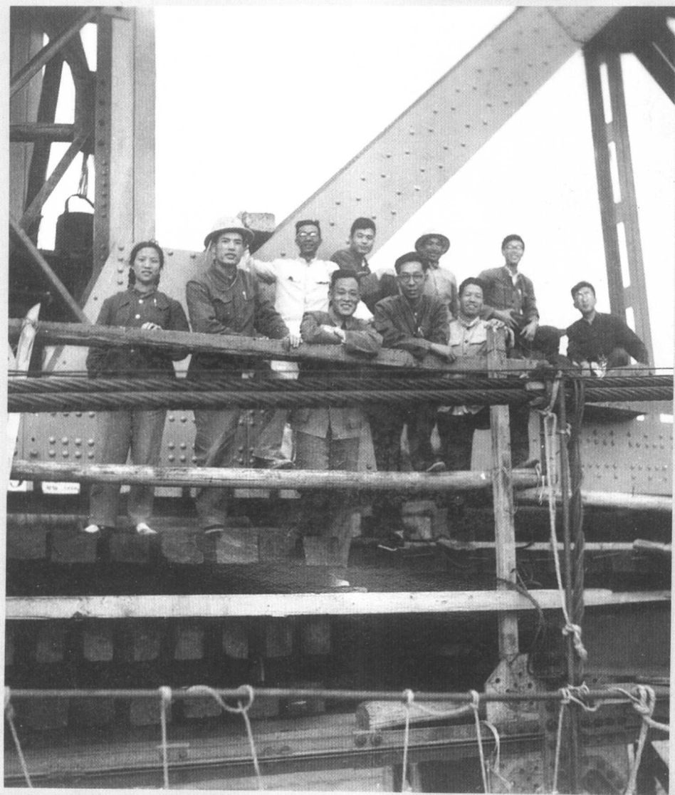
1968 年汪永宁学友在兰新铁路甘肃铁镜山专用线一号桥工地（桥高100米）
