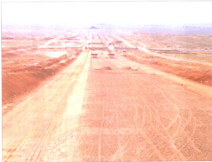
小洼槽倒虹吸工程全貌及埋置式玻璃钢夹砂管（RPM管）线
