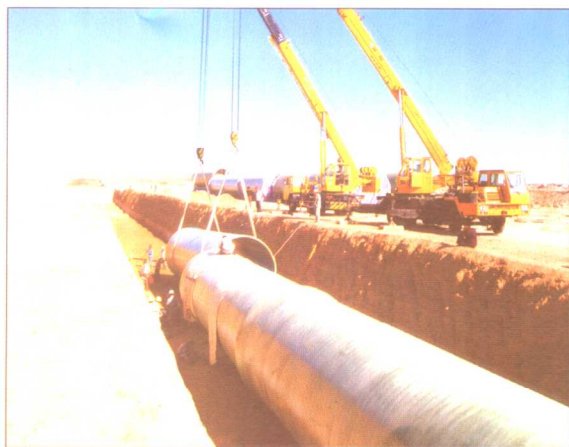
小洼槽玻璃钢夹砂管对接
