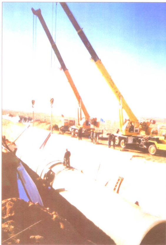
小洼槽玻璃钢夹砂管现场安装
