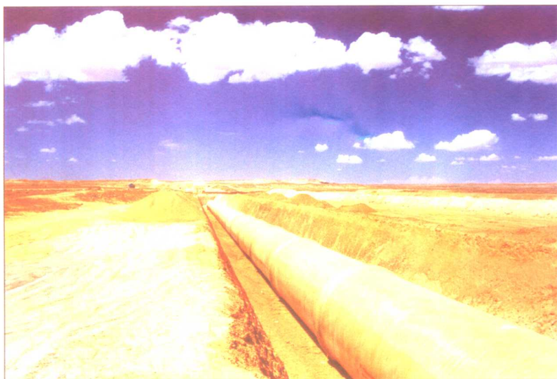
安装后的口径为3100mm的玻璃钢夹砂管道
