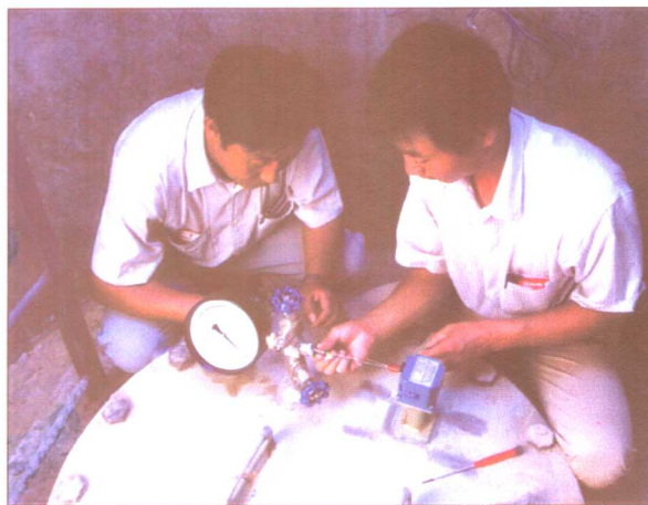
管道石英晶体压力传感器安装
