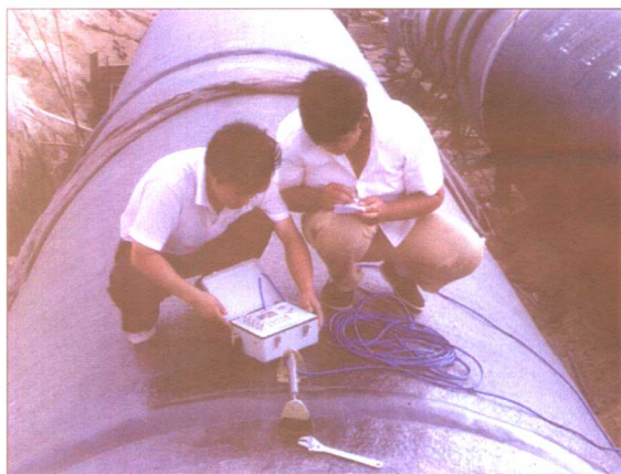
三个泉PCCP管接缝仪器安装
