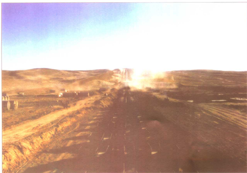
三个泉倒虹吸工程压力钢管镇墩施工
