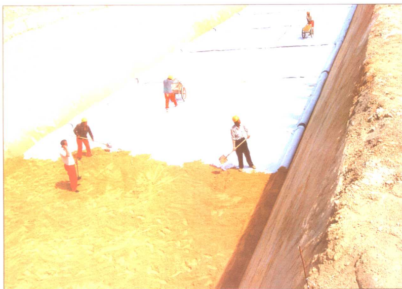
PCCP管道安装基础处理
