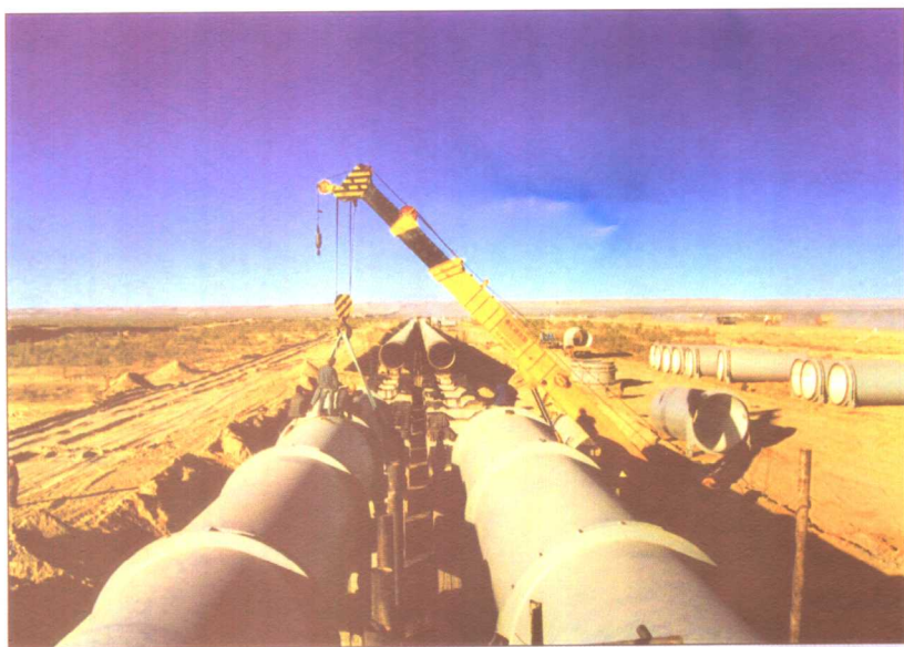
三个泉倒虹吸口径为2700mm、承受内水压力为1.6MPa的钢管安装
