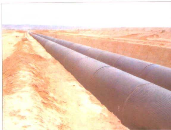
安装后的PCCP管线
