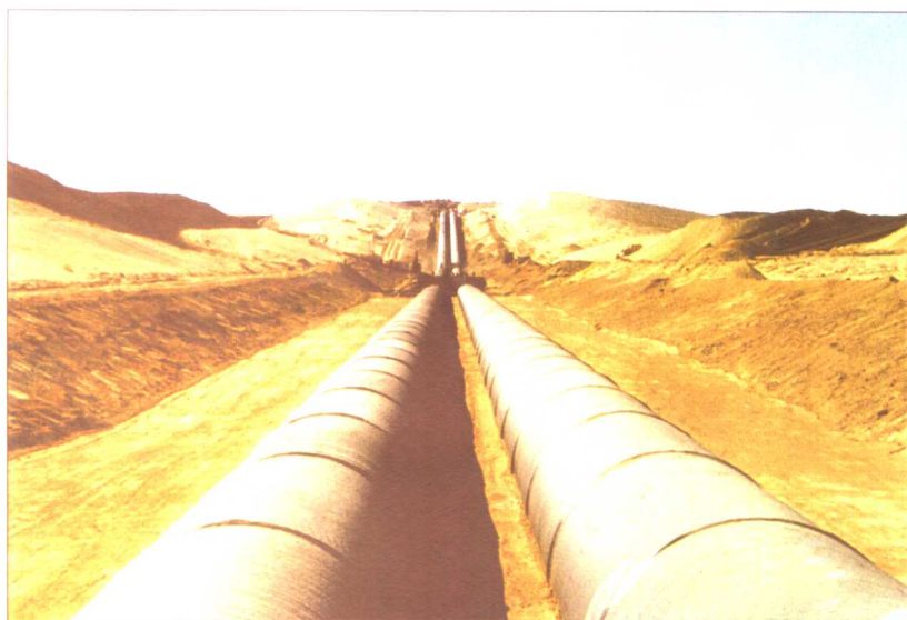
三个泉倒虹吸口径为2800mm、承受内水压力为1.4MPa的PCCP管
