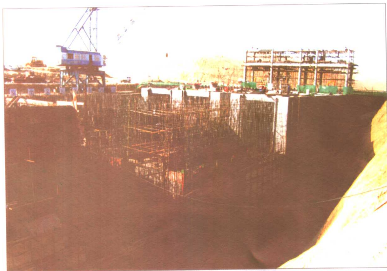
三个泉大洼槽进水口混凝土浇筑
