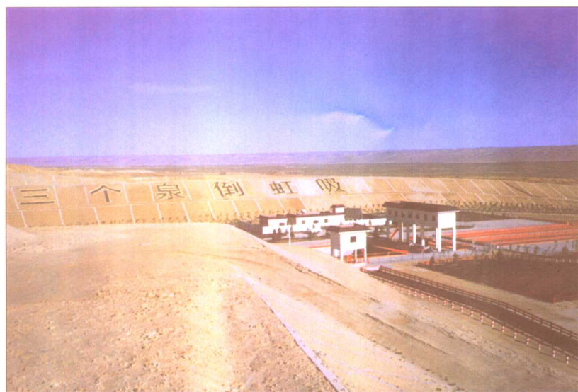
三个泉倒虹吸进水口布置
