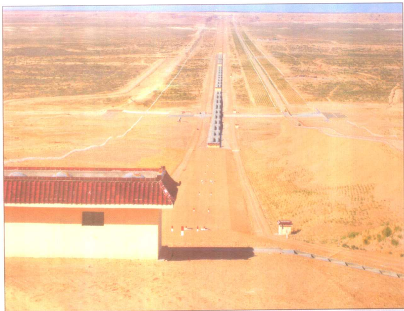
大洼槽倒虹吸工程全貌
