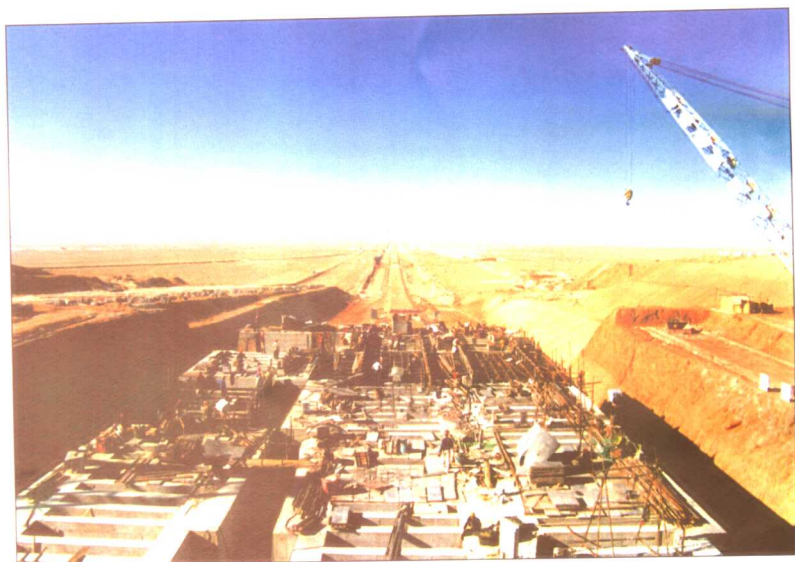
三个泉大洼槽进水口施工
