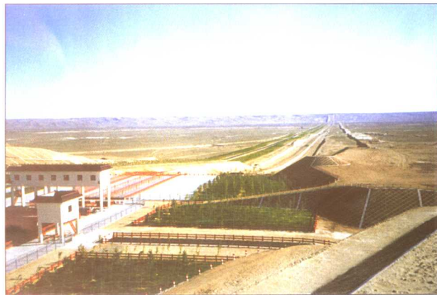
三个泉倒虹吸管线长11km，管沟深160m
