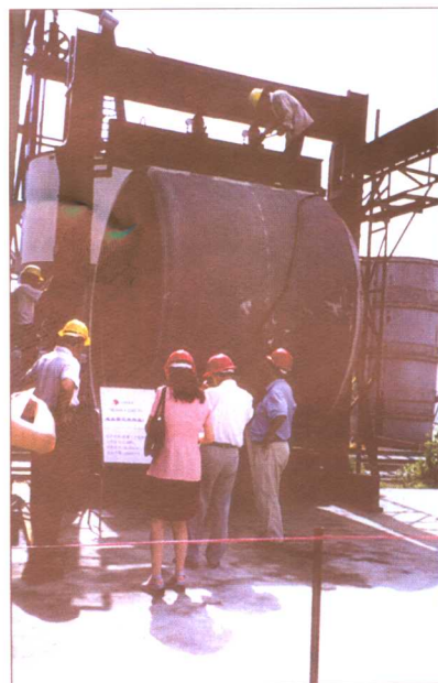
PCCP管出厂前进行外压检验
