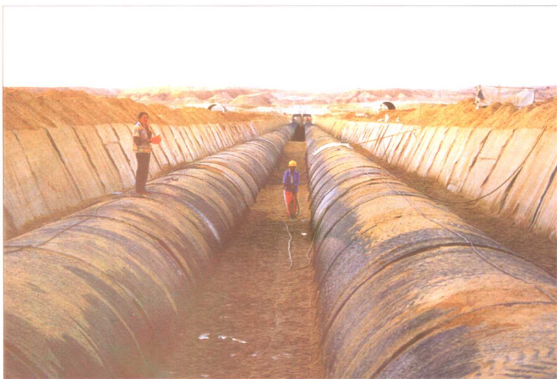
PCCP管道安装回填
