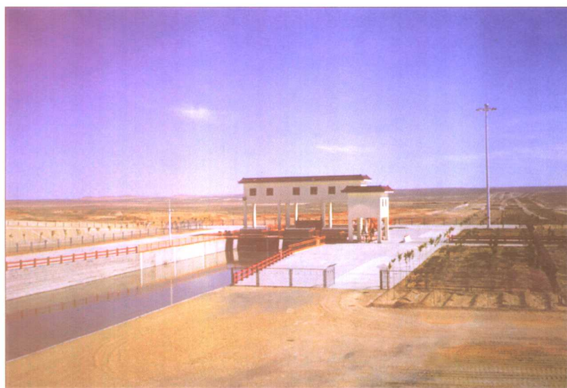
小洼槽倒虹吸进水口
