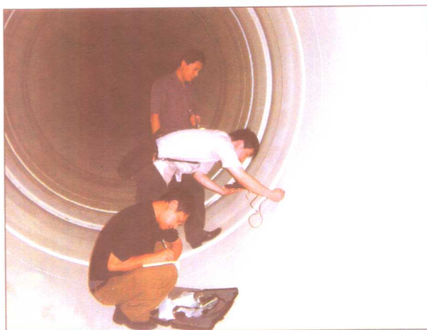
PCCP管对接后，进行接缝的质量检测
