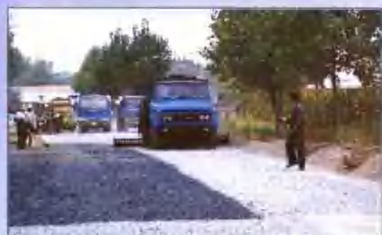
朱韩路施工现场
