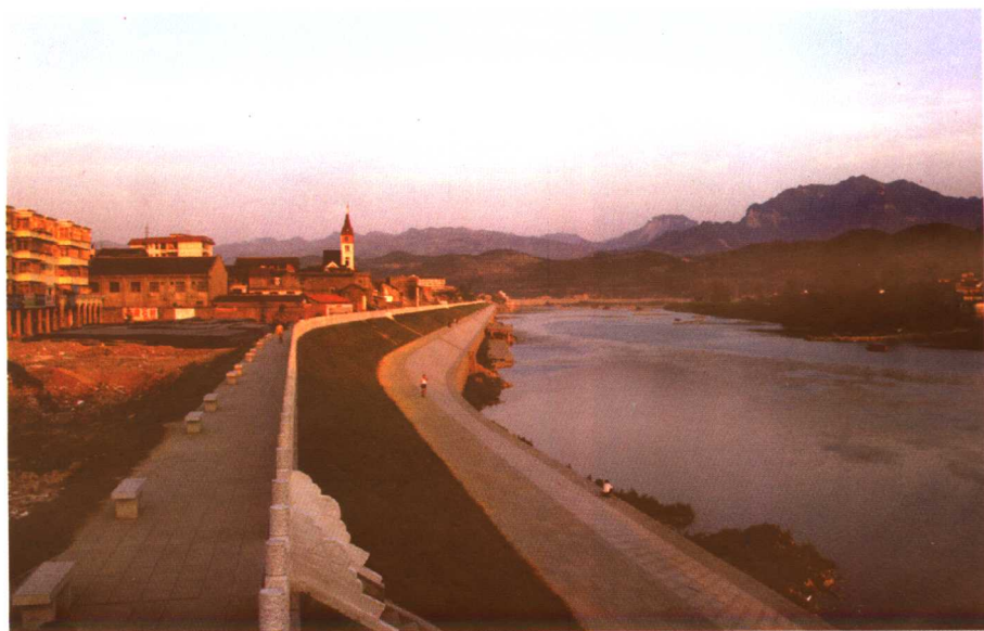
张家界新建城市防洪大堤
