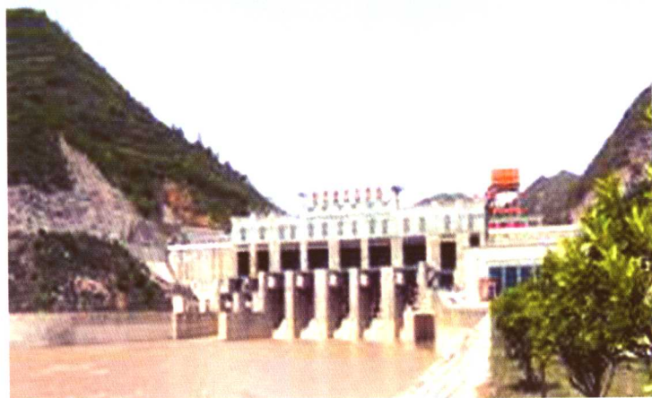
改造后的渠首枢纽大坝
