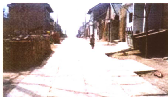
利用废弃的混凝土板铺巷道
