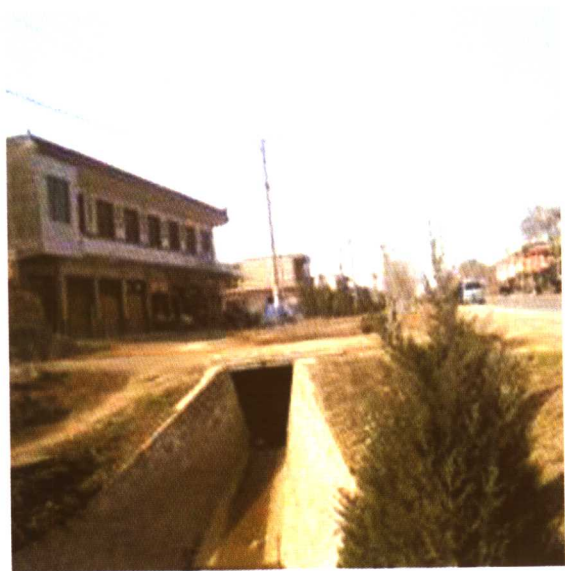
过村镇渠道加盖防止污染
