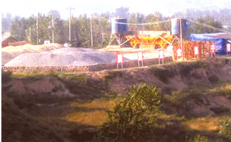
整改后的施工料场
