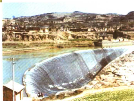
改造前的渠首枢纽大坝
