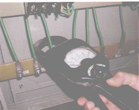
用钳形电流表测电流
