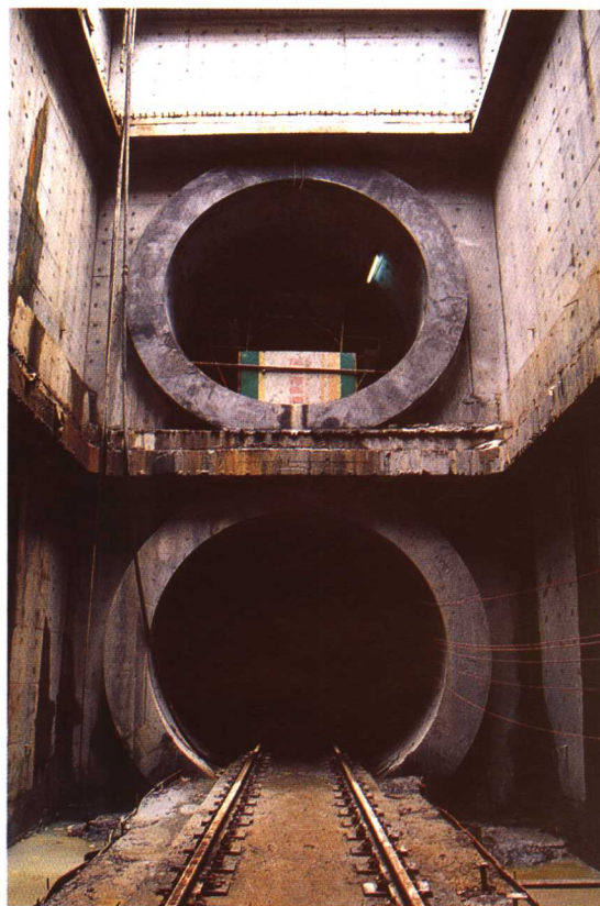
盾构双洞双层重叠隧道
