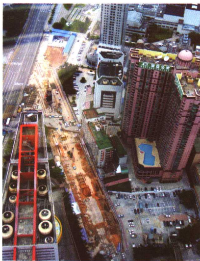
大剧院站施工现场
