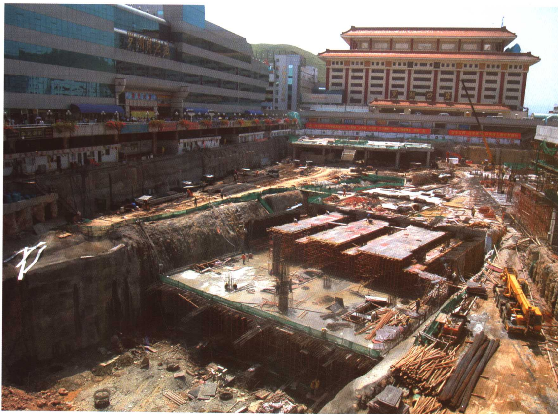
地铁罗湖站施工现场
