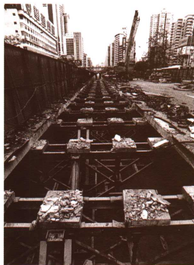
华强路站盖挖工地
