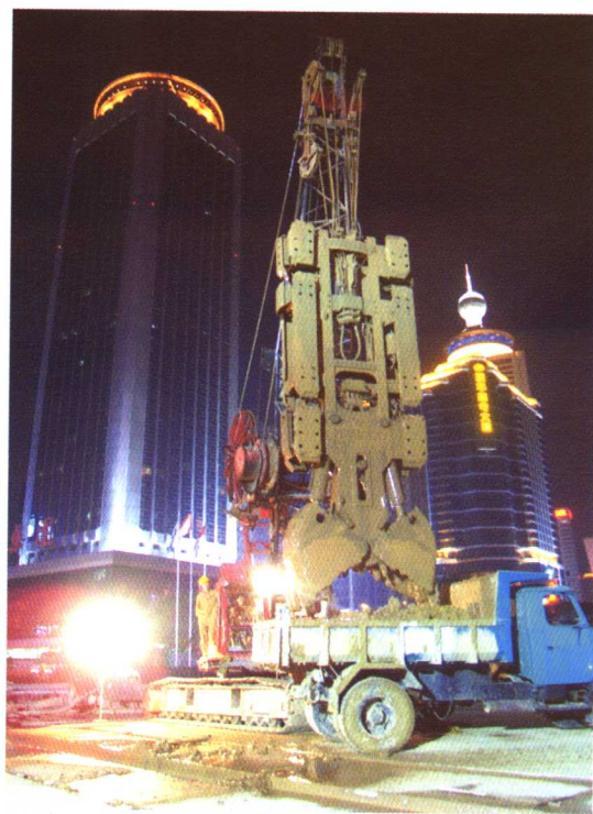
国贸站施工现场
