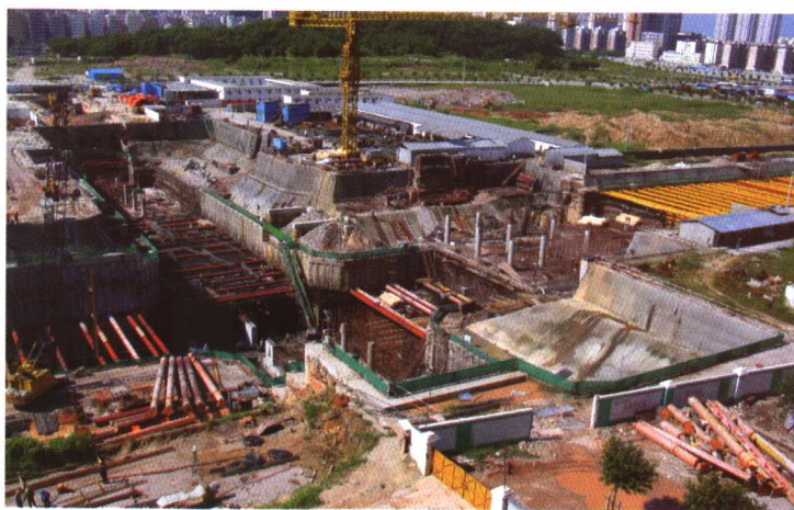
会展中心站施工现场
