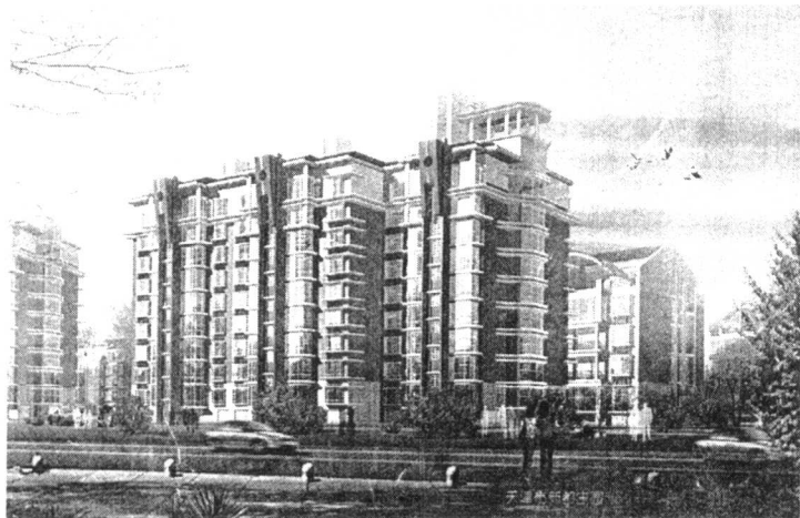
图 1.3-3 天津市金厦新都庄园异形柱结构示范建筑
