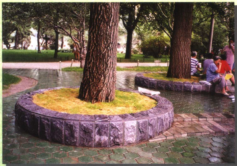
树池的边缘石高出地面，既保护树木根区免受游人踏实，又为游人提供了树荫下的休息场所
