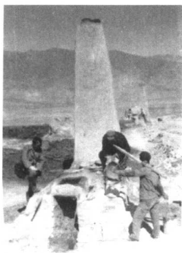
图 1-2 土法生产硼砂的炉灶
