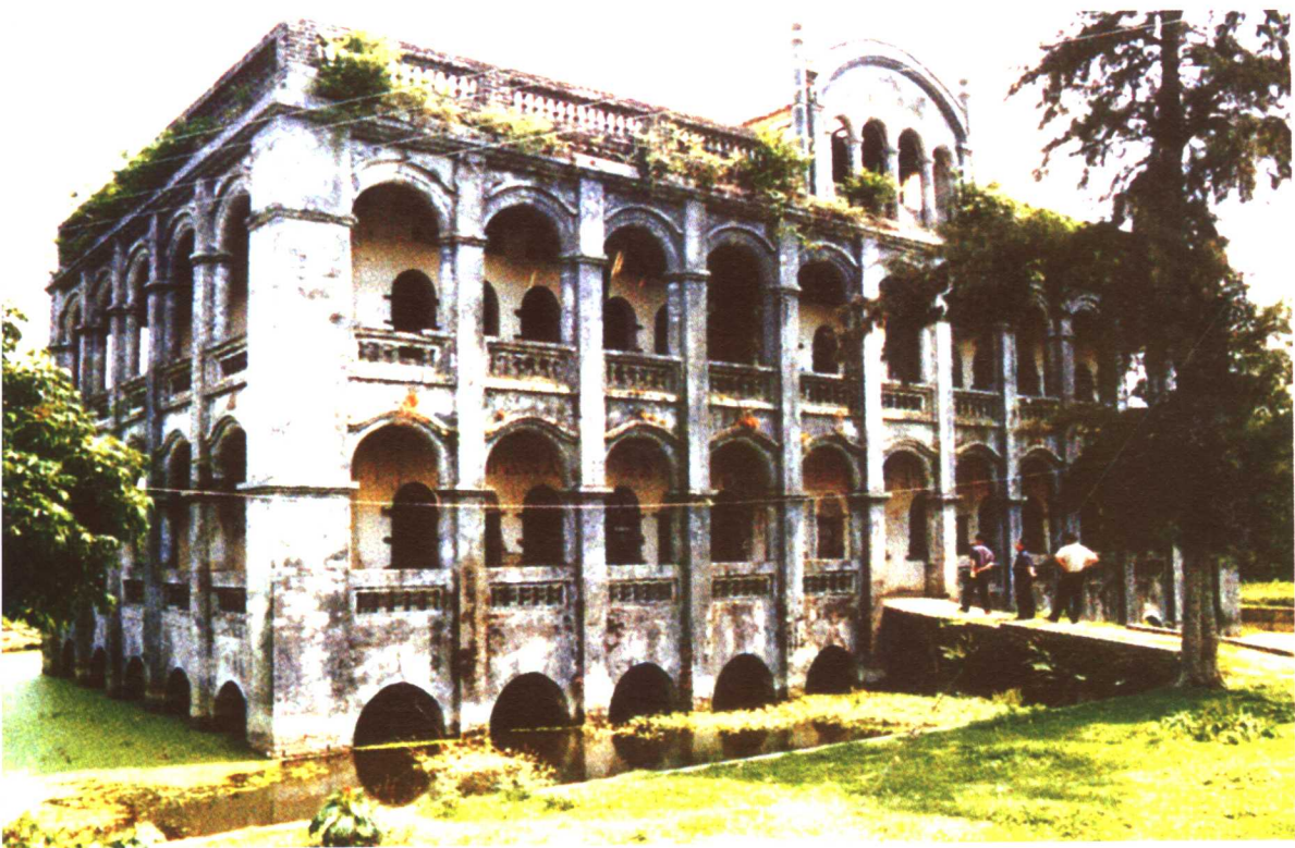
博白县太平坡客家水楼。
