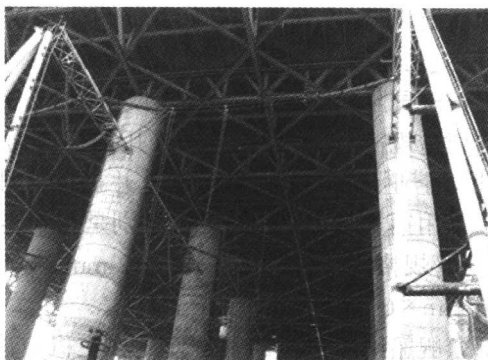
图 1-2 600 MW 直接空冷机组钢结构空冷平台支撑结构
