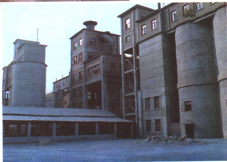
县水泥厂机房一角
