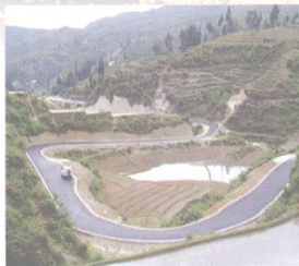
县际油路黄南公路
