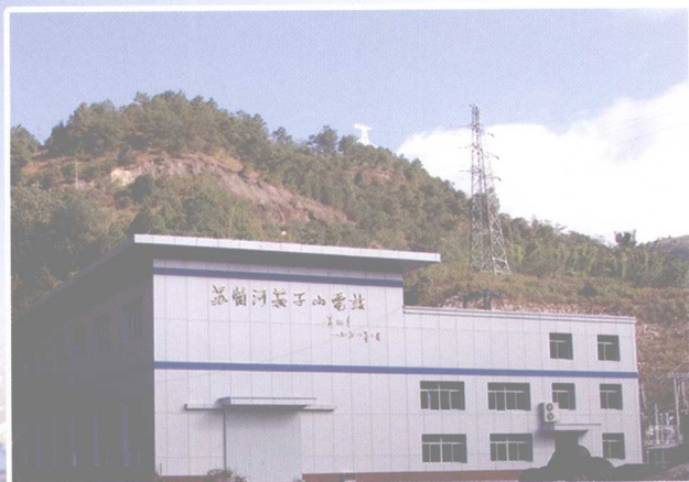
装机1.6万千瓦的茄子山电站
