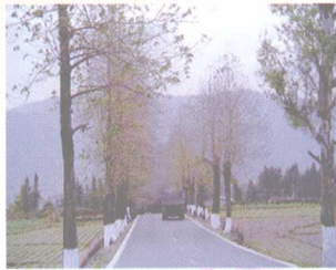
通县油路腾梁路
