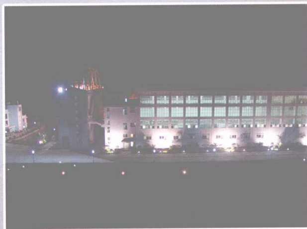
装机11.55万千瓦的阿鸠田电站
