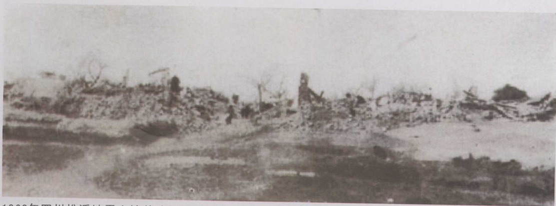
1960年四川松潘地震土墙普遍倒塌之情形
