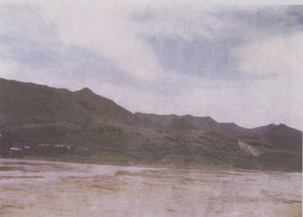
重庆云阳故陵镇巨型滑坡全景
