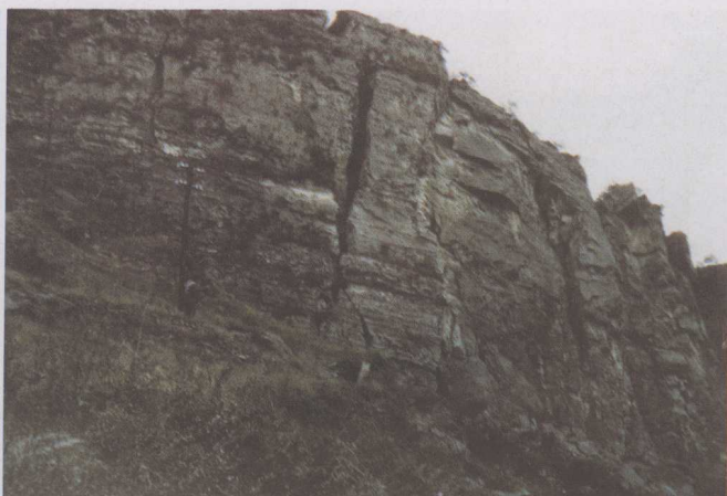
三峡链子崖危岩体T0-T5裂隙
