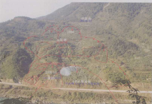
湖南皂市水阳坪—邓家嘴滑坡全貌(处理前)
