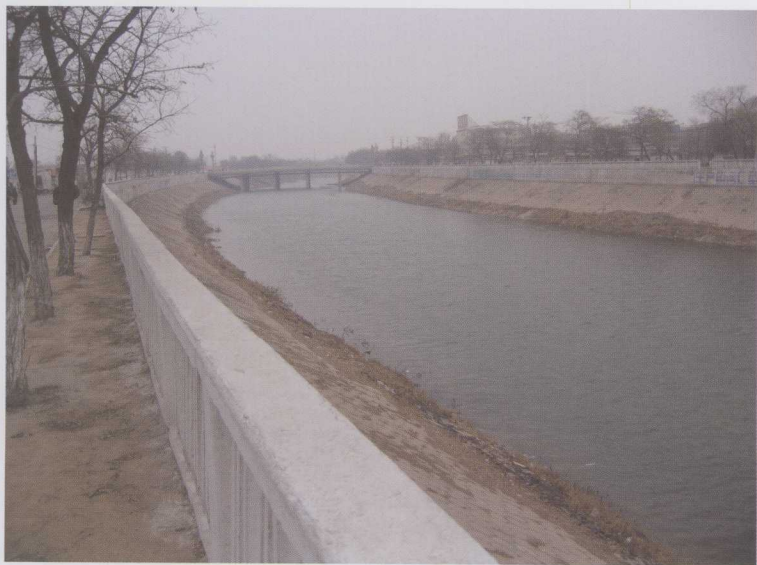
图2 纵贯泊头 市区的京 杭大运河
