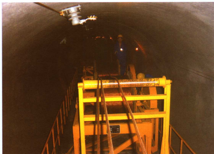
接触网安装施工
