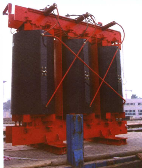
会展中心站动力变压器开箱检查
