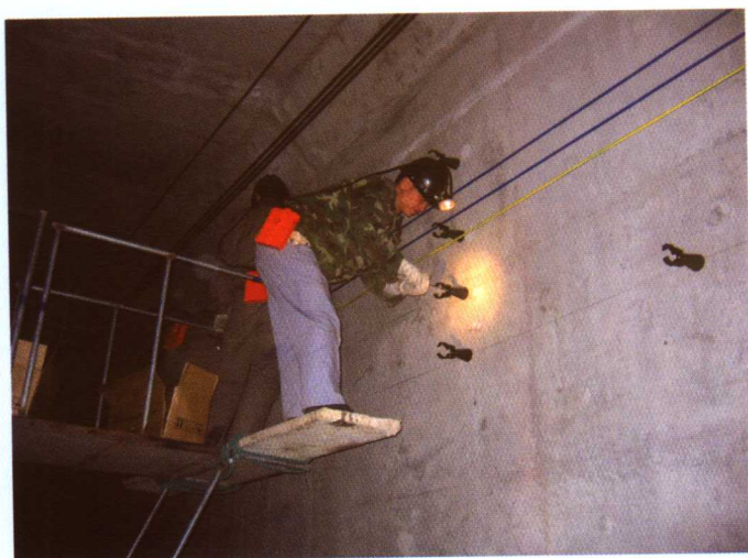
施工人员在隧道壁上安装无线漏缆吊夹
