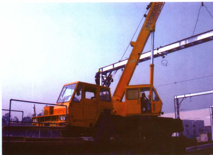
安装接触网硬横梁
