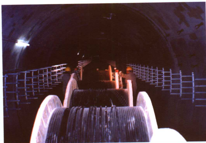
敷设地铁通信系统光缆——由中铁三局电务工程有限公司安装
