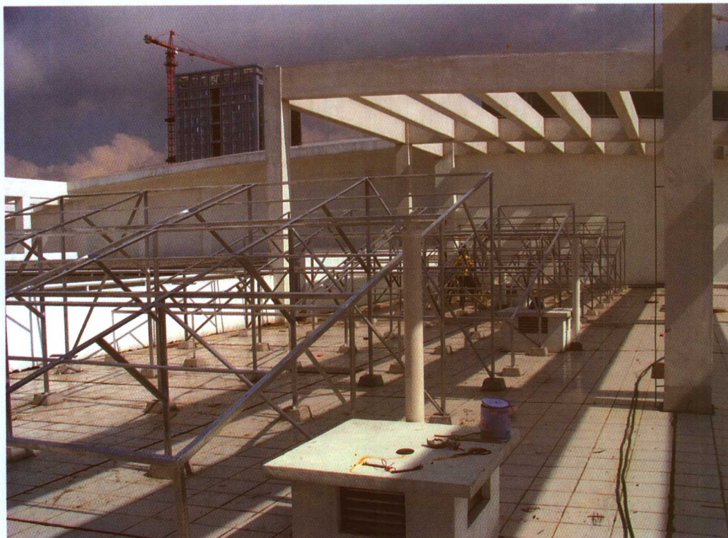
车辆段运营综合楼太阳能集热供水系统在安装中
