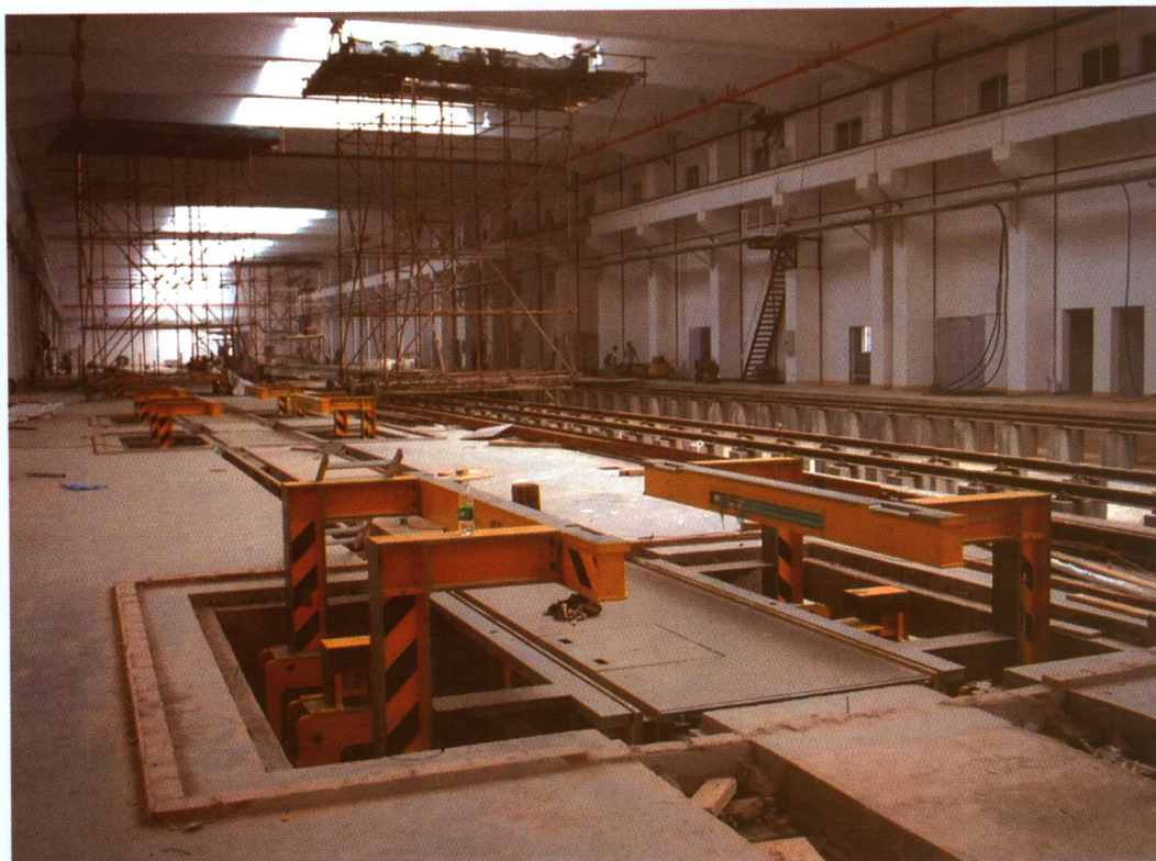
安装中的固定式架车机
