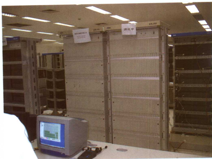
地铁程控电话交换机调试
