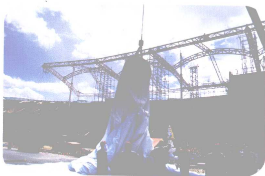
体育中心施工建设场景
