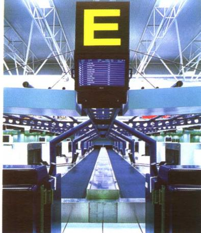
北京首都国际机场2号航站楼是中国目前规模和运输量最大的航站楼，作为重要的交通枢纽，航站楼要全面、综合地处理好机场内人流、物流和信息流的复杂关系，形成安全、准确、方便、高效的候机和工作环境，为旅客提供良好的服务是设计的根本出发点。此外，设计从可持续发展的观点出发，充分考虑旅客的安全性和便利性，航空服务的协调性和扩展的适应性，经济的有效性和形象上的标志性。建筑立面以流畅匀称的曲线形金属屋面和采光天窗相结合，配以虚实相间的弧形金属墙，形成富有交通建筑特点和时代特色的外观。入口处波浪形的雨篷使入口和车道边十分突出。室内处理以暴露结构展现空间变化为主要手段，厅室布置力求朴素、明朗、简洁，富有时代特色。大厅采用花岗石地面，铝合金复合金属板墙面，吊顶除金属方板、条板外，还有浮云式曲线板材。候机厅堂与进港通廊空间流畅并且富于高低变化，加上外露的结构，形成让人联想并富有特色的内部空间。
