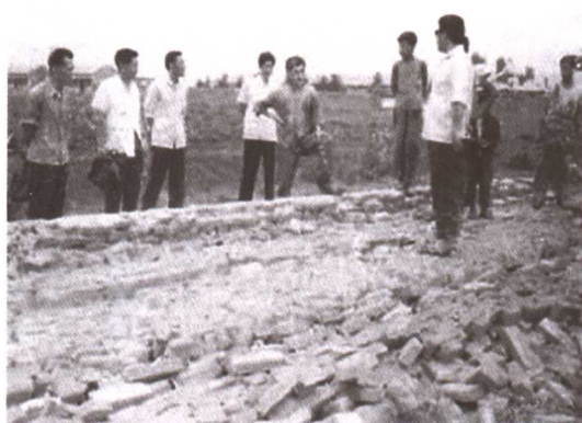
1981年7月8日,枣庄出现龙卷风,市气象局在吴林食品站进行灾情调查,龙卷风在此强烈旋转,造成吴林食品站围墙南北向的朝东倒,东西向的朝南倒
