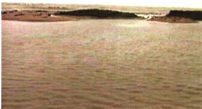
1992年8月31日至9月1日，受16号热带风暴影响，日照沿海防护坝被冲垮
