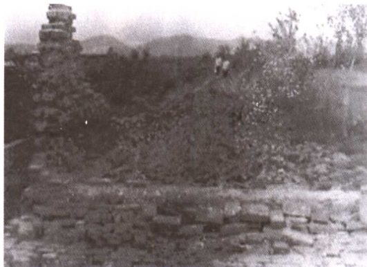
1981年7月8日,枣庄出现龙卷风,市气象局在吴林食品站进行灾情调查,龙卷风在此强烈旋转,造成吴林食品站围墙南北向的朝东倒,东西向的朝南倒
