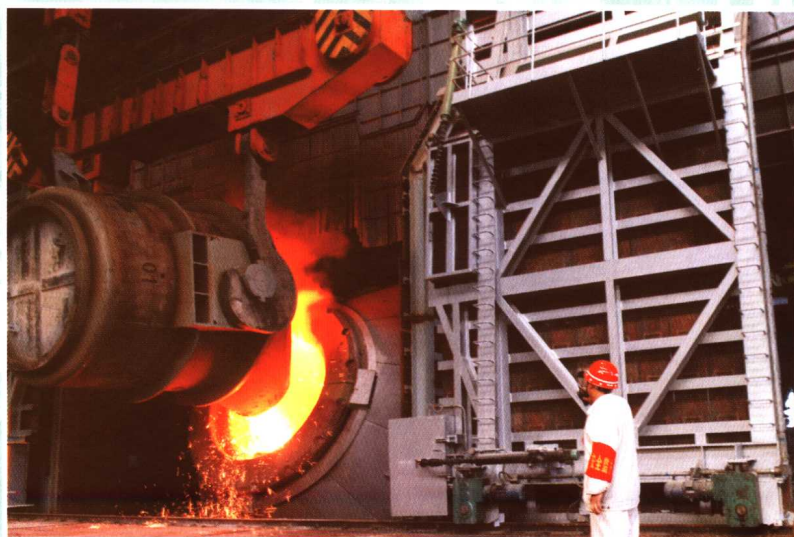
10月20日投产的 120t转炉工程
