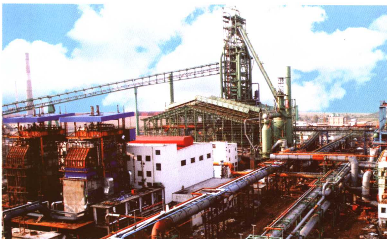
10月15日投产的 2200m 3 高炉工程
