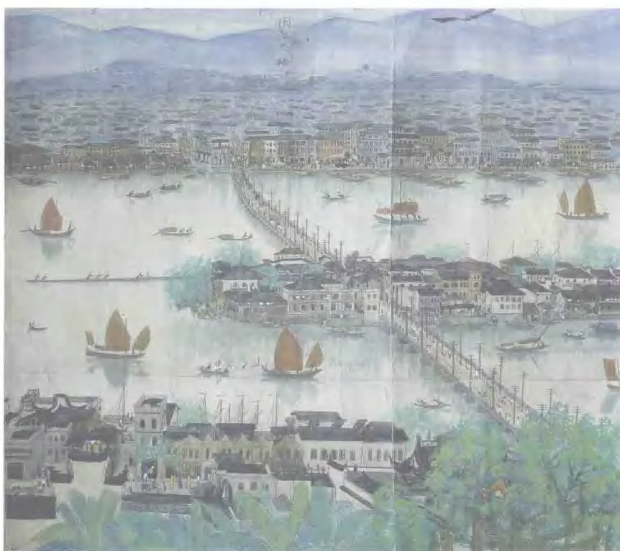
福州闽江大桥“旧居”，1962年。
