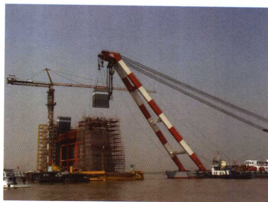
▲ 钢混结合段安装
