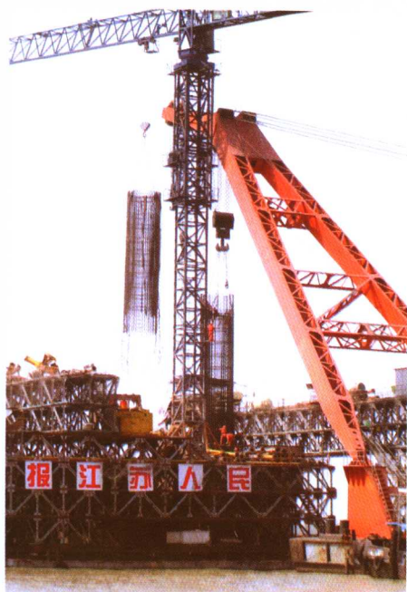
▲ 吊放桩基钢筋笼
