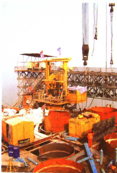
▲ 桩基钻孔施工
