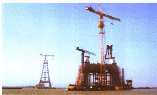
▲ 钢塔柱节段吊装现场
