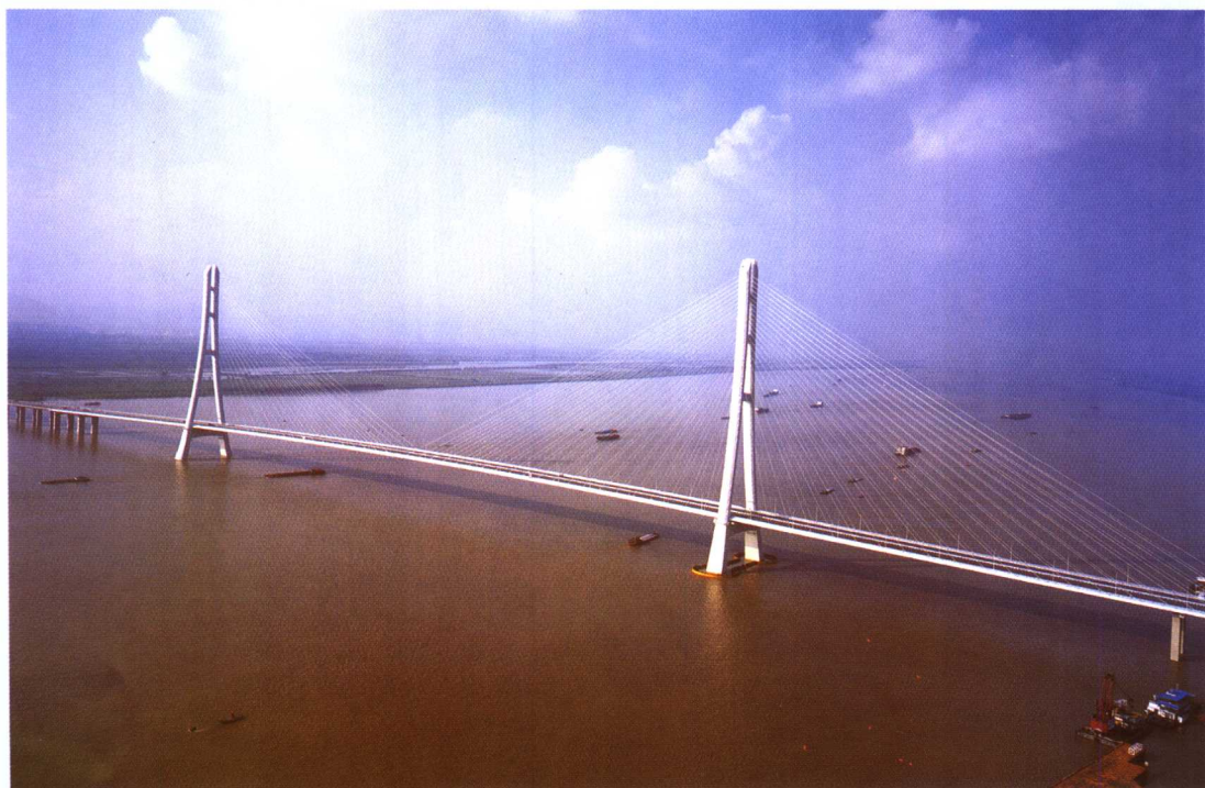
▲ 建成后的南京长江第三大桥
