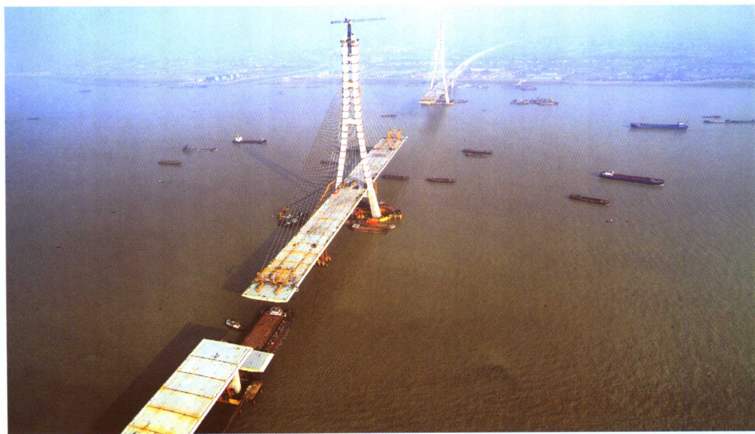
▲ 南京长江第三大桥主桥建设全貌
