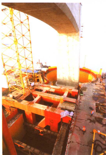
▲ MD3600 塔吊支撑托架
