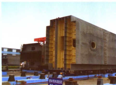
▲ 钢塔节段箱体加工
