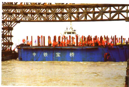
▲ 南塔钢套箱首节浮运
