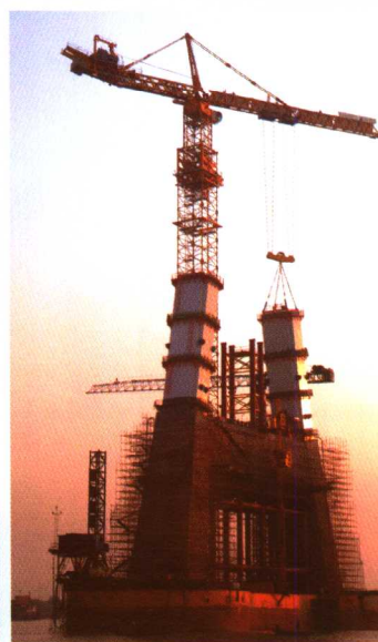
▲ 塔吊吊装钢塔柱
