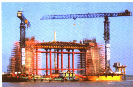
▲ 下横梁底模施工
