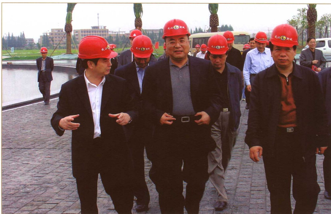
中共浙江省委常委、杭州市委书记、杭州市人大常委会主任王国平(前排中)视察杭州大剧院 工程建设现场
