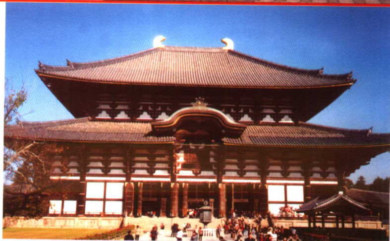
3 东大寺 ——日本最大的木结构建筑
