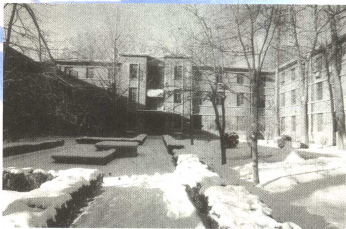
图1-4 国防部五院一分院旧址——地处北京市长辛店的马列学院二分院
