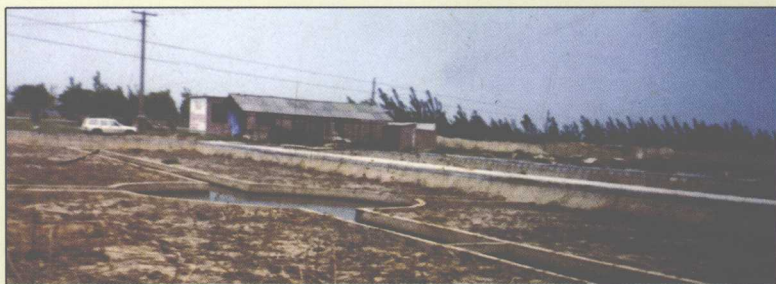
硬化池内修建的鱼沟、鱼溜
