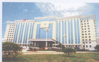
北湖区政府大楼
