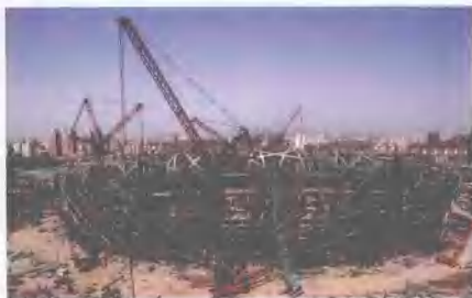
奥体中心鸟巢大型钢结构吊装工程
