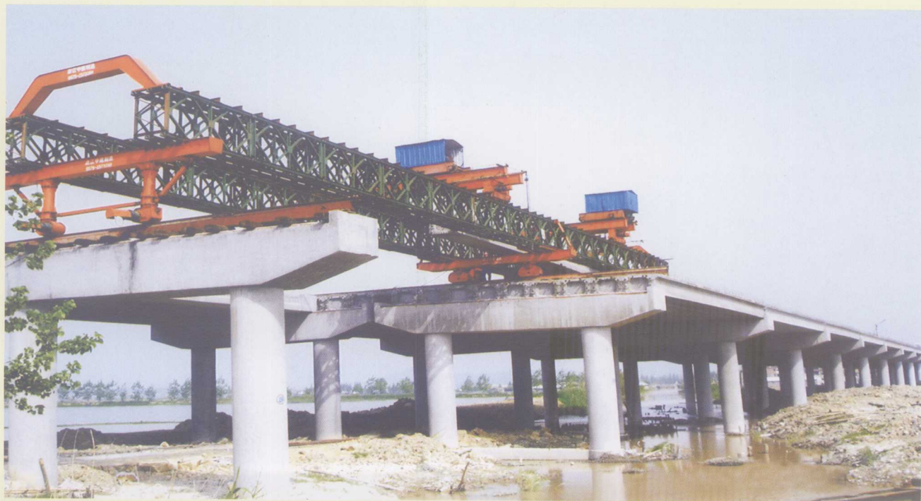
▲ 诸永高速公路诸暨段高湖沿桥施工场面
